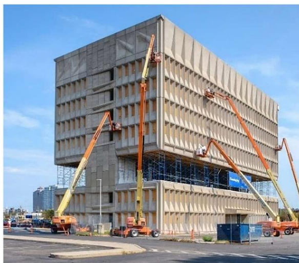
Figura 2. Aplicação de película sobre concreto aparente em Edifício Administrativo transformado em Hotel sustentável, 2020
