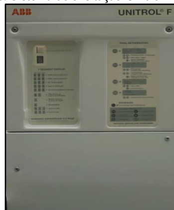
Figura 6. Sistema de excitação Unitrol F, da ABB
