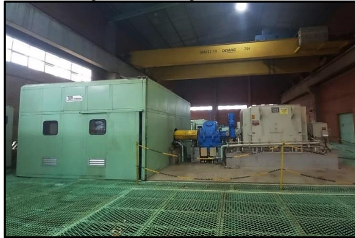
Figura 3. Turbina e gerador síncrono.
