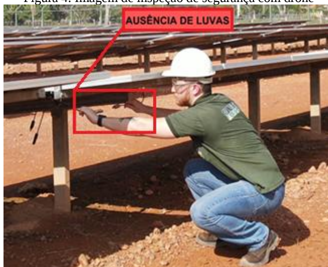
Figura 4. Imagem de inspeção de segurança com drone
