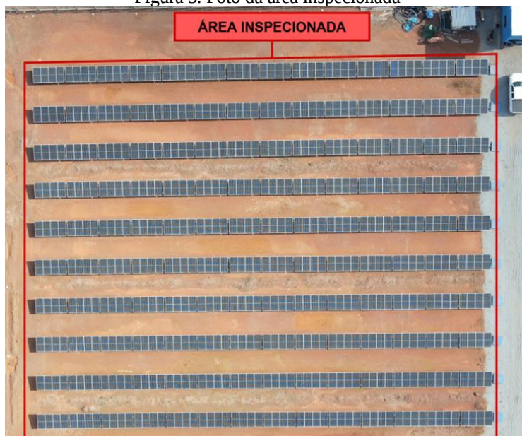
Figura 3. Foto da área inspecionada
