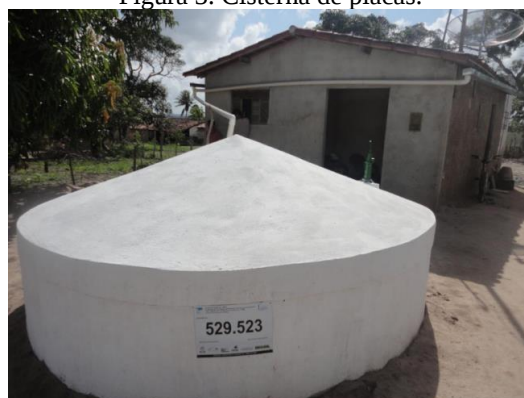
Figura 3. Cisterna de placas.
