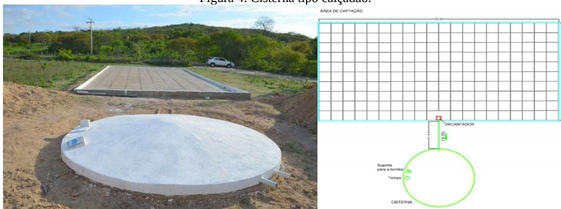
Figura 4. Cisterna tipo calçadão.
