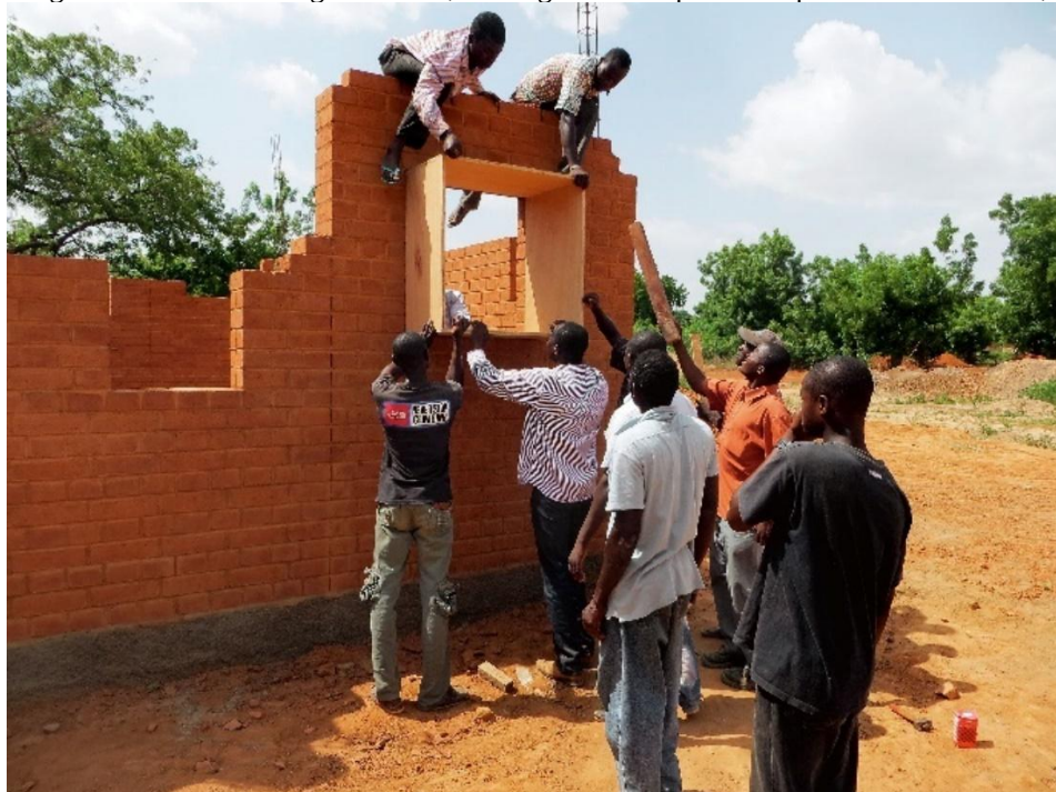
Figura 16: Clínica Cirúrgica de Leo; montagem das esquadrias e processo construtivo;
