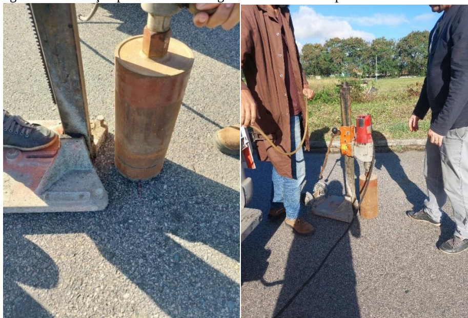
Figura 7 – Avaliação por meio de sondagens das camadas do pavimento do trecho “S” .
