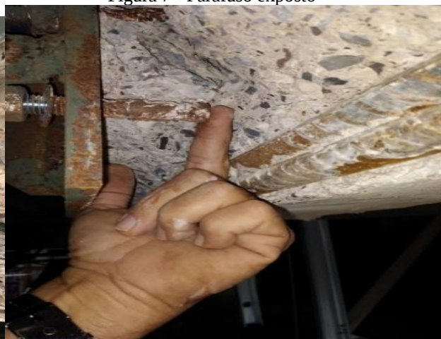
Figura 7- Parafuso exposto
