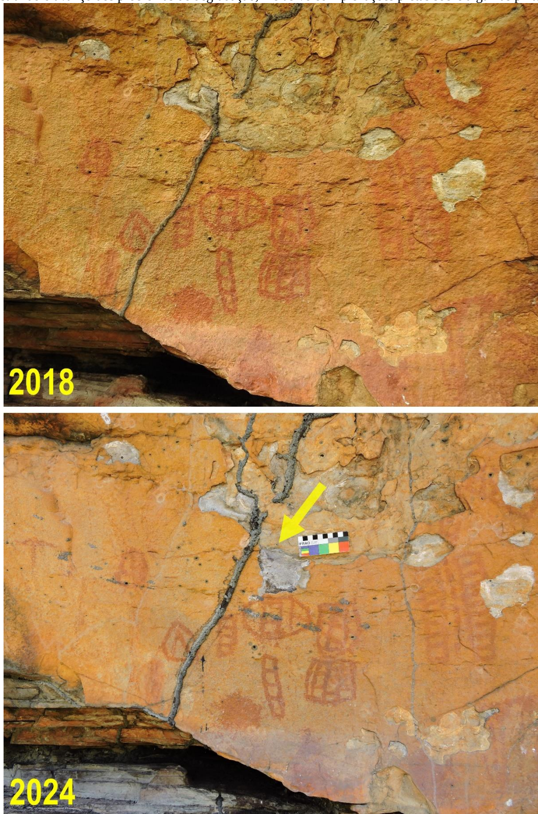
Figura 7: Detalhe do painel de pinturas rupestres do sítio arqueológico Furna do Andrade em 2018 e em 2024, mostrando o avanço dos problemas de degradação, inclusive com pichações pretas sobre algumas pinturas.
