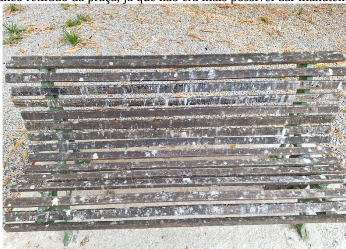
Fotografia 27 - Banco retirado da praça, já que não era mais possível dar manutenção adequada 2023
