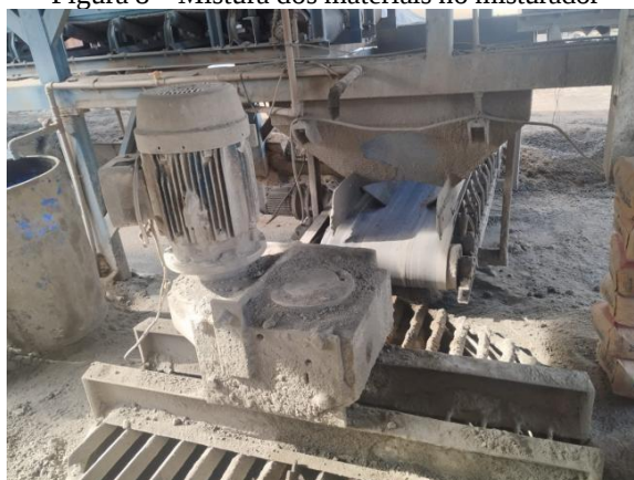
Figura 8 – Mistura dos materiais no misturador
